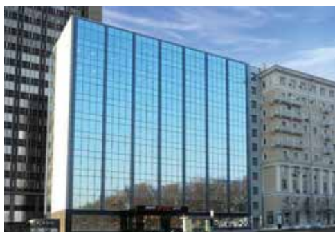
Бизнес-центр «РТС» Земляной Вал г. Москва, ул. Земляной Вал, д. 50А, стр. 3
